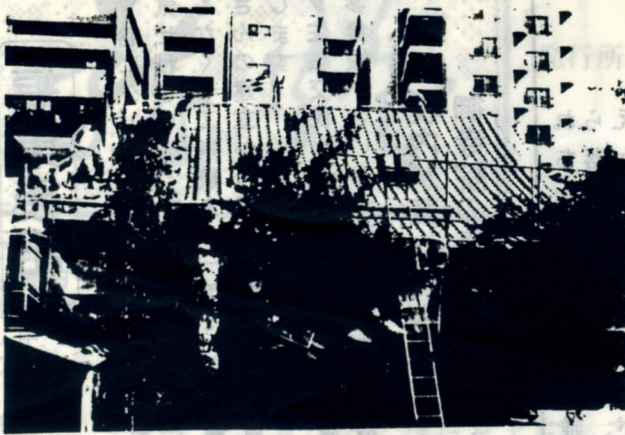
本堂屋根瓦葺き替え工事 正面内部も同時に大改修工事
