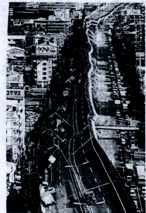
神戸市東灘区にある被災地の様子。多くの建物が倒壊し、瓦礫が散らばっている。
